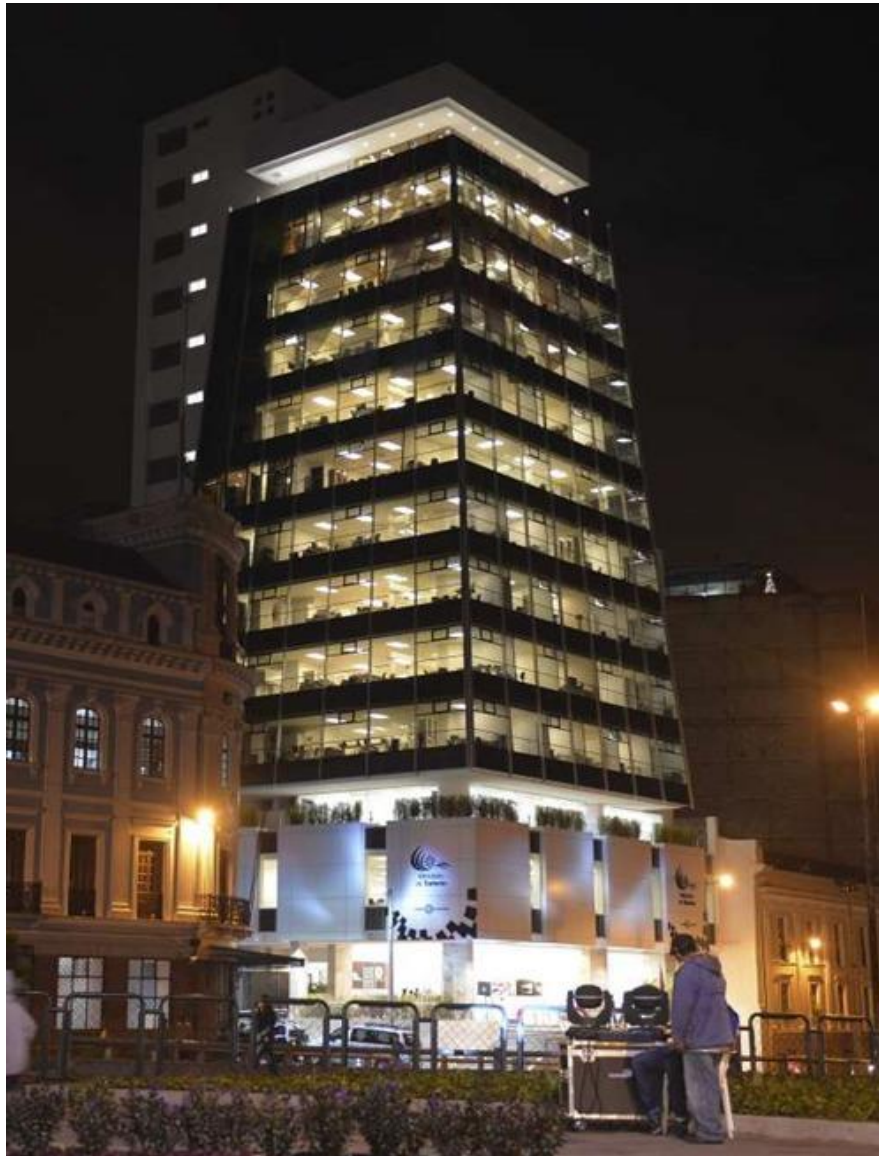
Fotografía 1: Edificio La Filantrópica MINTUR Fuente: Archivo Institucional MINTUR
